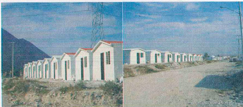
83 Tecnoviviendas construidas en la Alianza, Nuevo León.
