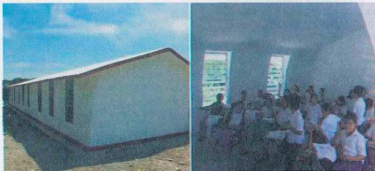
Tecnoaulas Construidas en Tapachula Chiapas.
