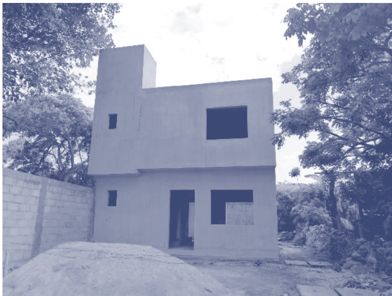
Imagen 2. Vivienda social sustentable construida.
