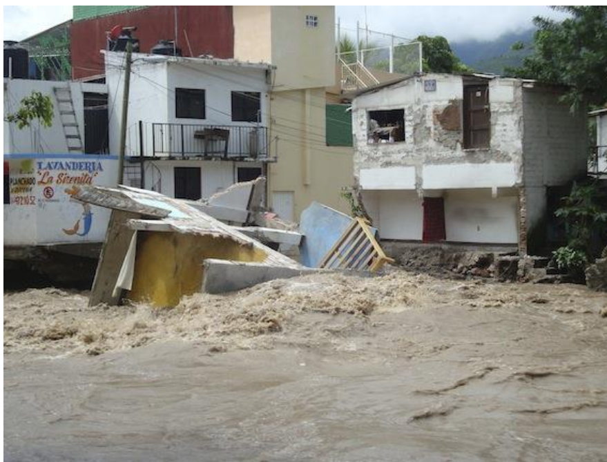
Imagen 3. Chilpancingo: Viviendas sobre margen de cuerpo de agua, 2013
